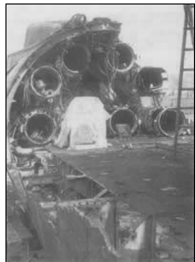
Blick auf die freigelegten Torpedoschächte
